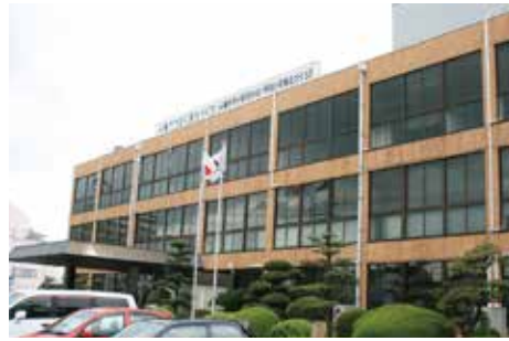
昭和37年に建設され 築62年になる市庁舎
